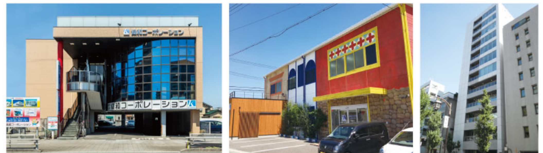
本 店 協和ハウスタジアム 協和丸の内ビル 名古屋本社
